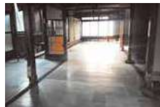
土間ベタ基礎
